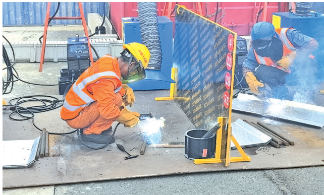
9月26日上午,无锡市国资系统工程建设钢筋焊接技能大赛在无锡地铁6号线和风路站举办。比赛分为理论知识竞赛和实操两个环节,来自无锡地铁3号线南延预埋隧道工程、4号线二期、5号线、6号线、S2线各土建标段及医疗健康产业园项目的25支队伍、50名选手共同参赛。(甄泽 摄)
