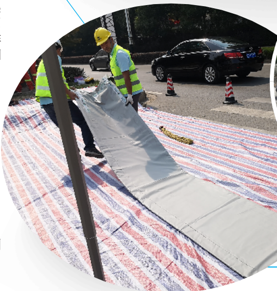
施工准备现场
