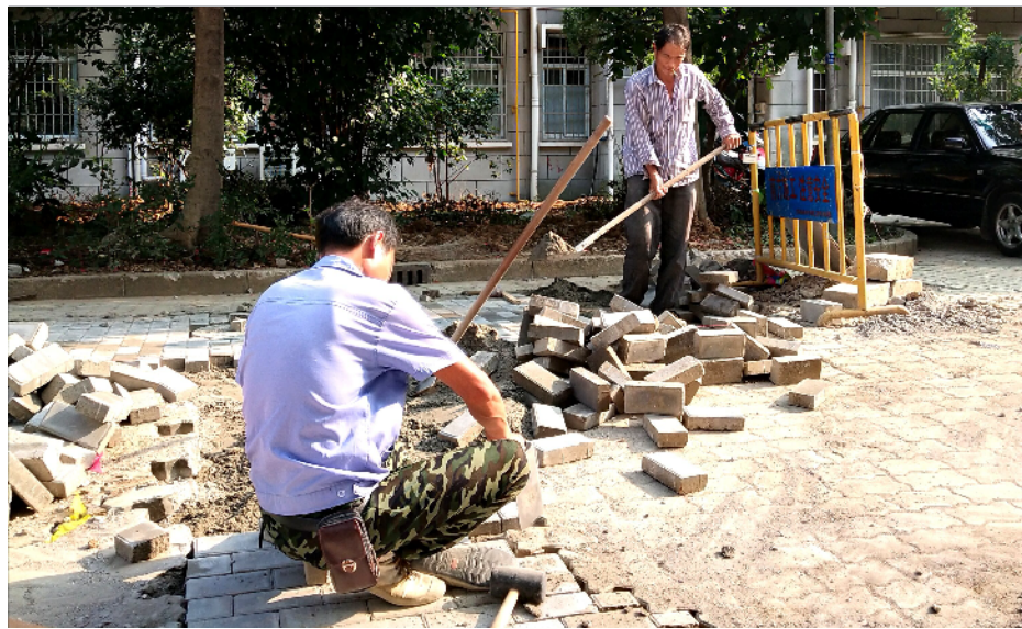
昨天，施工人员在惠畅里施工。梁溪区新一轮老新村改造全部展开，听松坊、西塔影苑等小区约70万平方米，进行雨污分流、停车位、墙面翻新等改造。
