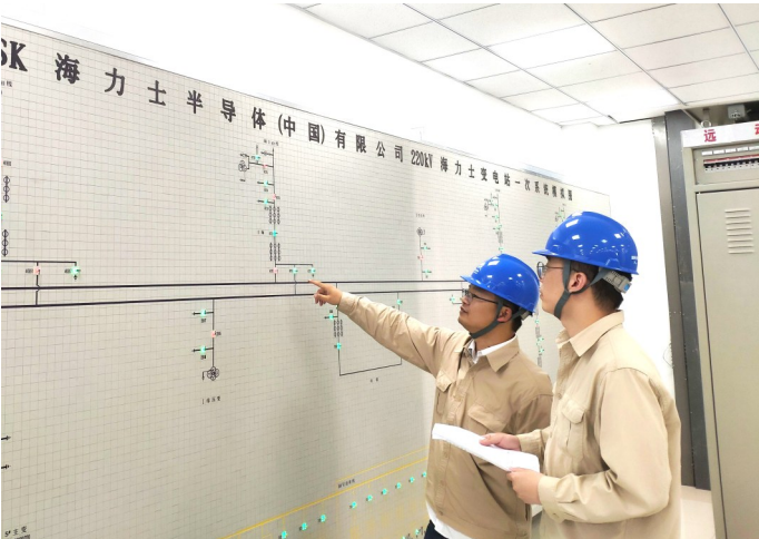
国网无锡供电公司大客户经理对接线方式,做海力士增容送电前准备。
