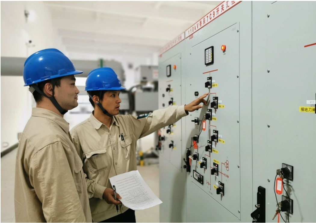
新区中心客户经理在高压用户海辰半导体公司进行巡视。
