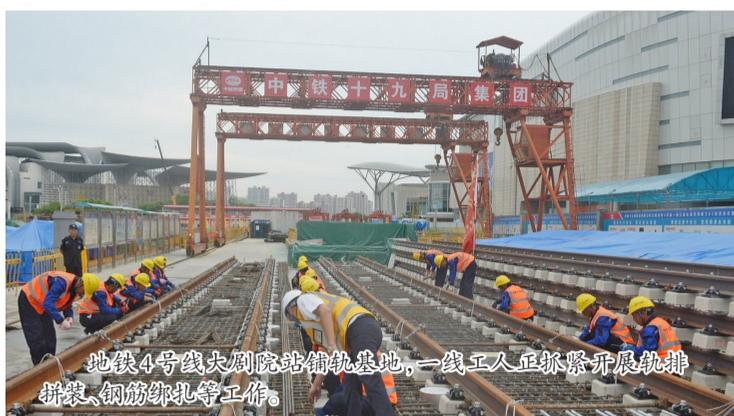
地铁4号线大剧院站铺轨基地，一线工人正抓紧开展轨排拼装、钢筋绑扎等工作。
