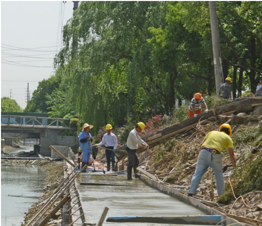
全长2338米的大寨河是广益街道的重点整治对象,近期进行清淤、控源截污、生态净化、景观提升等施工,旨在为周边居民营造良好的环境。图为昨天施工人员在浇筑亲水平台。(陈大春 摄)
