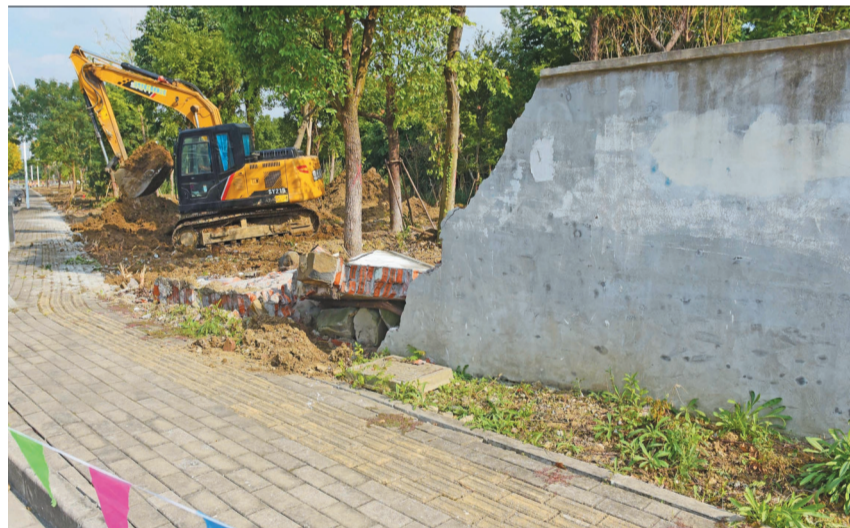
昨天,清舒道西侧的一处拆墙透绿施工现场,挖掘机在作业。近日,太湖新城对清舒道与清晏路交叉口西南处的待开发地块进行拆墙透绿,拆除围墙、补栽树木、铺种草坪。(还月亮 摄)
