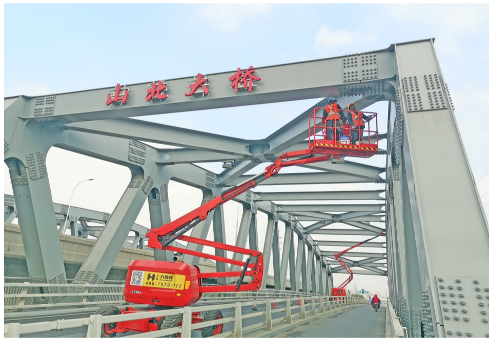
昨天，施工人员对山北大桥进行油漆。日前，市政部门对山北大桥等大运河上的标志性桥梁维护保养，更好地扮靓锡城景色。(陈大春 摄)
