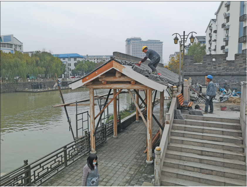
昨天，工人在古运河妙光苑段亲水平台建造观景休闲亭。近几年，梁溪区古运河管理部门在环城古运河边的水仙桥、南门、三里桥等处陆续修建了此类休闲亭，成为市民健身、休息的好地方。
