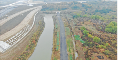
清水河改河及亲水道改路
