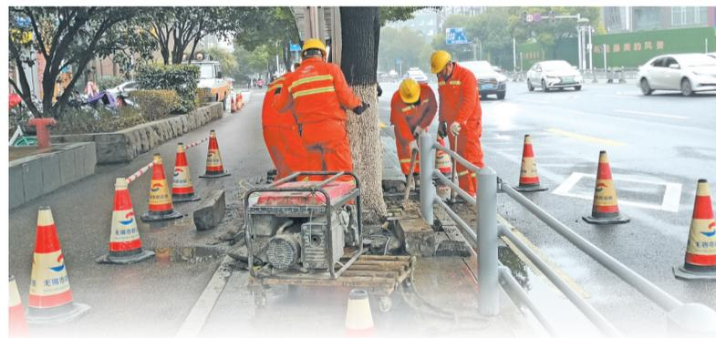
整整齐齐,道路面貌焕然一新。按照高标准、精细化要求,无锡市市政设施建设工程有限公司统一对市管道路的细节进行“精微绣”。值得一提的是,本次侧石修复应用了新材料,“这种混凝土可在半小时内快速硬化,由于新材料本身具有微膨胀性,可以更好地连接破损部位,修复后的路面不易产生裂缝。”彭正说,下一步还将改进工艺,在新材料中添加新物质,使得成型后的“补丁”经过打磨后与原有路面达到浑然一体的效果,实现道路的功能性和颜值双提升。
