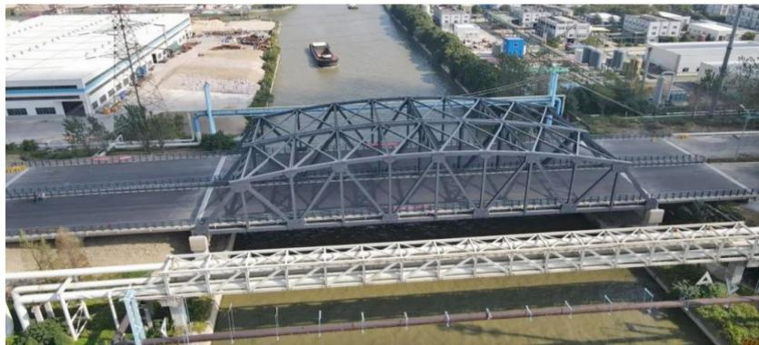
板梁；桥梁下部结构采用柱式墩、桩柱式桥台、钻孔灌注桩基础；路面采用沥青路面，路基标准断面宽度31.5米，设计时速80公里。该桥建成试运行将为公路、水路提供更加安全便捷的出行条件。
