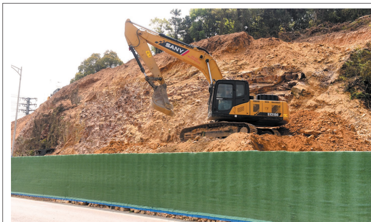
近日,雪浪街道相关部门组织施工人员在—处地质灾害隐患点采取削坡清坡作业,并将采取喷土、栽种爬墙类植物等措施排除地质灾害的隐患及进行生态修复工作。图为挖掘机在这处地质灾害隐患点施工。(还月亮 摄)
