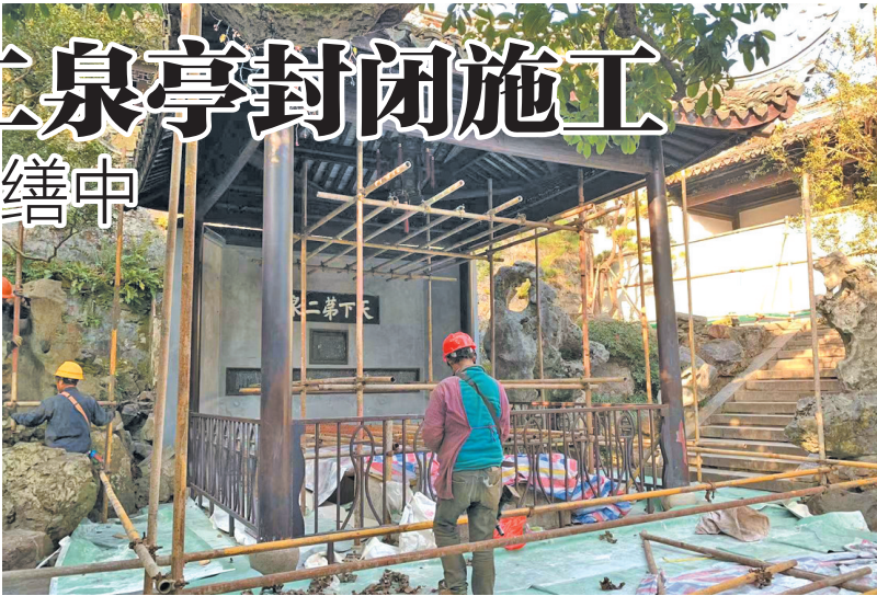
惠山古镇内的施工现场
