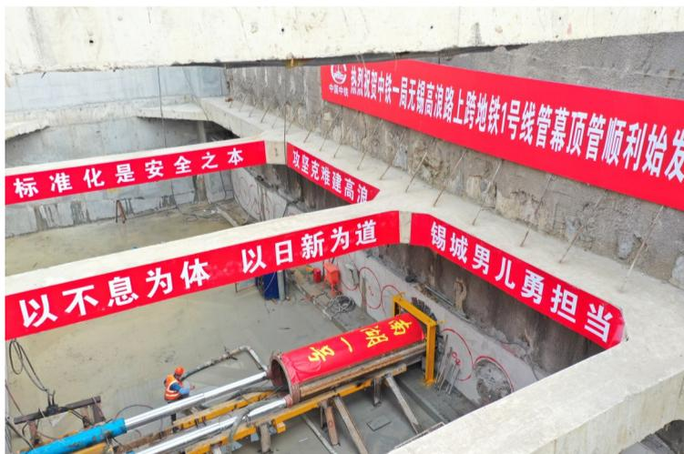
长34.3米,内径1.2米,壁厚20mm钢管组成,采用2台开挖直径1.26米的泥水平衡顶管机进行施工。该设备采取全封闭式顶进的方式,可有效保持挖掘面的稳定,对管道周围的土体扰动小,能很好控制地面沉降,减小地层土体损失,确保1号线隧道安全。”辛保成表示。
