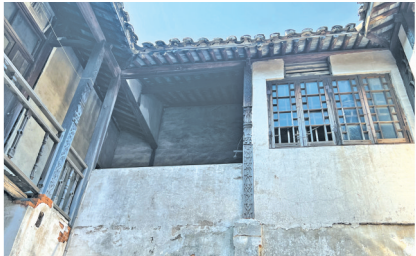
西侧楼房墙面
