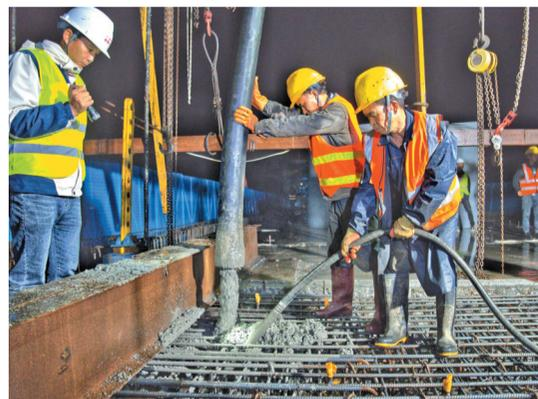
中铁十局施工人员在广湛铁路长兴村特大桥跨沈海高速连续梁合龙段浇筑混凝土(3月29日摄)。
