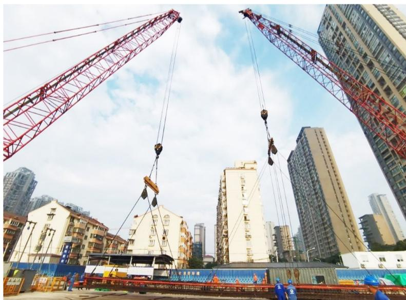
式进入实质性施工阶段。据工程项目方介绍，新华路站位于新华路与泰伯大道交汇处，毗邻梅里古镇、新梅广场及泰伯花苑小区，人流量大、地下管线错综复杂，管线产权单位较多。无锡地铁会同参建各方严把材料设备进场验收关、技术安全培训交底关，严控施工安全质量，尤其在起重吊装的高风险环节，确保地连墙施工安全、有序进行。此外，在钢筋笼制作、成槽施工检测、混凝土
