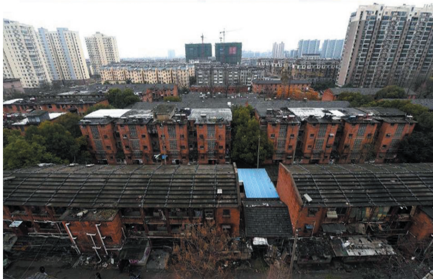
拼版照片：上图为2023年8月3日拍摄的改造后的安徽省合肥市瑶海区安拖东村及新庄城中村改造项目（无人机照片）；下图为2015年3月拍摄的改造前的安拖东村及新庄城中村旧貌。（新华社）
