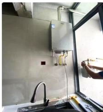
终于迎来热水器安装刺客了 热水器安装材料 754...
