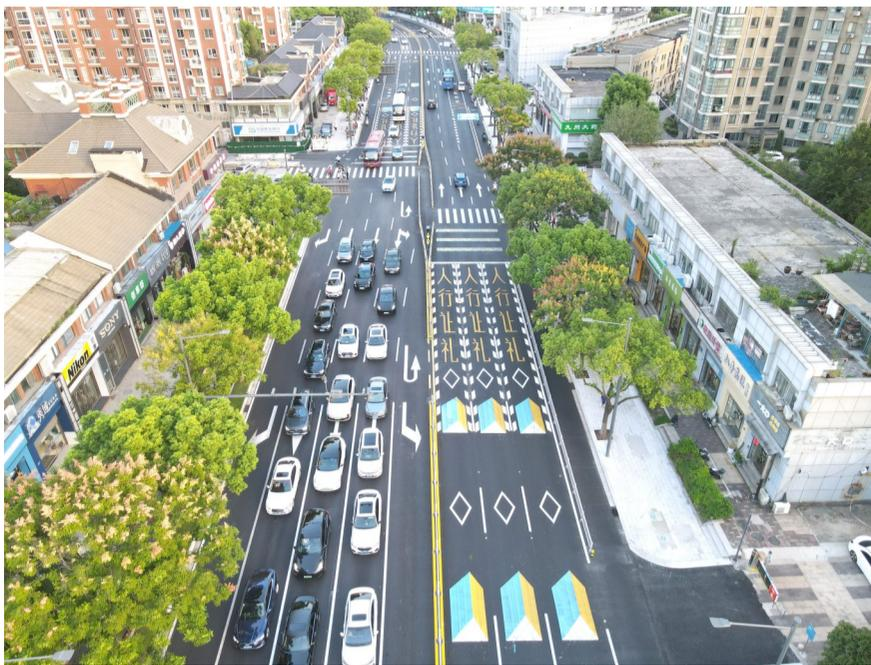
的安全性。同样醒目的还有路面的“巴登堡纹”标线，以其独特的纹理设计提高了道路标线的防滑性和可视性，而立体的减速标记则通过视觉错觉原理，使驾驶员产生减速的错觉，从而主动降低车速。
