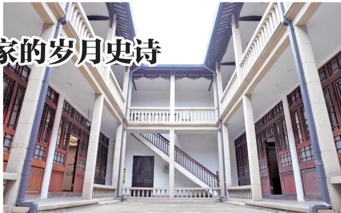
建筑平面为回字形结构,这是无锡地域典型的“转盘楼”布局。南北主要布置房间,东西各有一楼梯,中间为内庭,青石板铺地,环以回廊连通;建筑外观呈现典型的江南民居特点,南北主房为两坡屋顶,山墙脊部高起防火墙,通过厢房的直线相接,形成一条高低起伏的天际线,山墙外窗饰以拱券。
