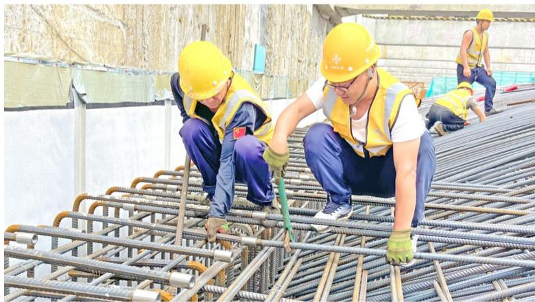
10月1日中午，无锡地铁6号线奥体中心站的施工现场，几名工人正将一根根9米长的钢筋按照施工需要切割成不同的长度，一旁的其他工人则将切割好的钢筋整齐地码放在指定区域，随后绑扎成钢筋笼，为后续混凝土浇筑做好准备。据悉，这个国庆长假，无锡地铁各新线建设项目持续推进，超3500名一线建设者分布在68个施工点位加速作业。
