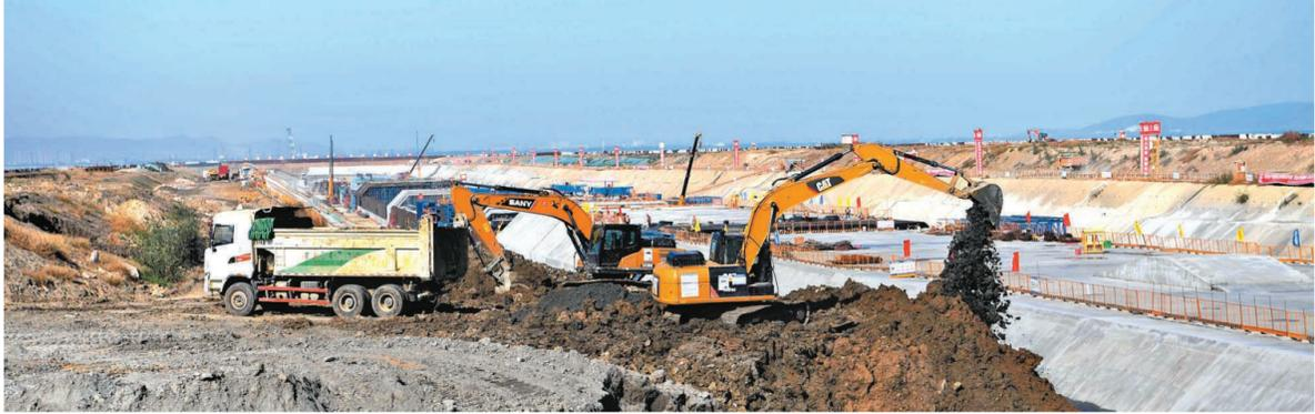
昨天,工人操作大型机械在苏锡常南部高速吴塘工区构筑二次横向围堰,为该区域恢复水面做最后的准备。据悉,该工区湖中一仓与岸上陆域段回填量达30多万立方米的土方回填工作已完成,目前正在构建隔离一仓与其他工段之间的二次横向围堰,预计该区域本月底将放水恢复太湖湖面。(刘芳辉 摄)
