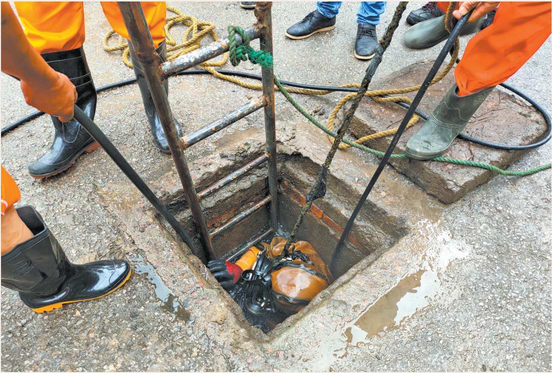
▲ 昨天上午,清名二村大面积积水,管网改造施工部门工作人员“蛙人”下沉到窨井内,把总阀门打开,增大窨井管线总排水量,积水迅速退却,保证了居民的正常生活。
