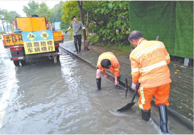
▲ 昨天上午,清名二村大面积积水,管网改造施工部门工作人员“蛙人”下沉到窨井内,把总阀门打开,增大窨井管线总排水量,积水迅速退却,保证了居民的正常生活。
