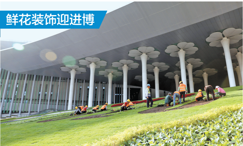
10月14日,园林工人在国家会展中心(上海)南广场进博会鲜花装饰草坪上施工。目前,位于上海青浦的国家会展中心(上海)南广场鲜花装饰工程正在进行中,迎接即将开幕的第三届中国国际进口博览会。(新华社发)
