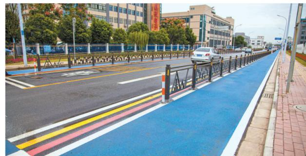
位于山北街道光电科技园内的金山北路原是园区货运路,路况不佳。随着产业升级,光电科技园由传统制造业园区向高科技研发、智能化制造园区迈进,因此街道对园区基础设施、道路交通、绿化景观等进行提升改造。金山北路改造从8月开始,对1500米长道路进行绿化带改造,对非机动车道进行彩色陶瓷颗粒路面改造,凸显出园区科技感和时代感。(吕枫 摄)
