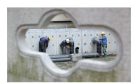
殷家河位于金海里小区内,是一条近50年历史的 城区河道,由于历史原因成为断头浜,各类污水常汇集 于此,河水经常呈黑臭状态。江海街道金海里社区在 河道一侧设置净化池,对水体进行几道过滤净化,进行 生态修复,还百姓一个景美水清的生态环境。图为工 人在净化池旁安装排水管道。 (朱吉鹏 摄)
