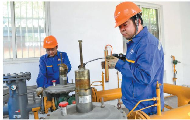
26日,工作人员在居民小区燃气调压房内进行安全检测及维护。“五一”将至,无锡华润燃气公司加强对居民小区、工商业用户燃气设施的检查维护力度,确保安全用气。(刘芳辉 摄)
